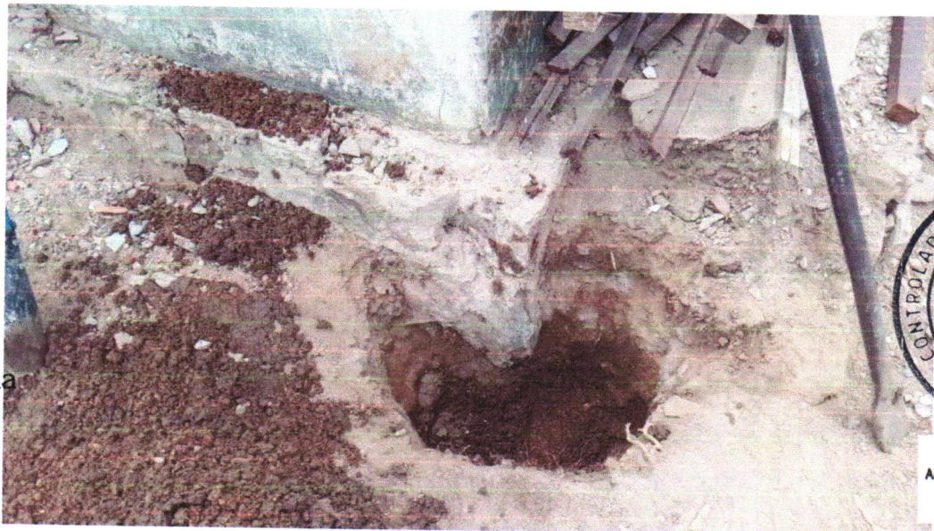
Foto 06 - ESCAVAÇÃO MANUAL DE VALA (INCLUINDO ESCAVAÇÃO PARA COLOCAÇÃO DE FÔRMAS). AF_06/2017
