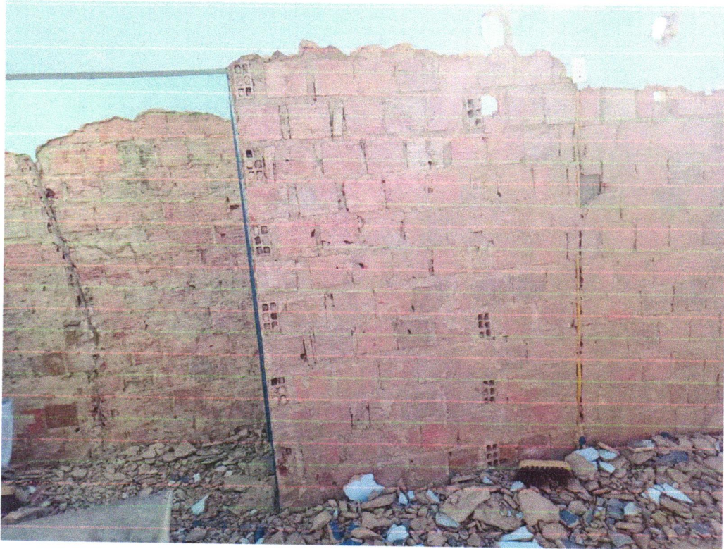
Foto 05- Demolição de reboco
