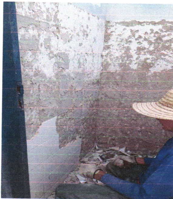
Foto 04 - Demolição manual de piso cimentado - Rev 01
