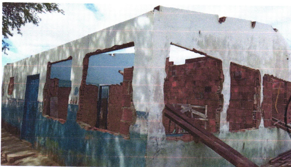
Foto 02 - Demolição de alvenaria de bloco cerâmico e=0,09m - revestida
