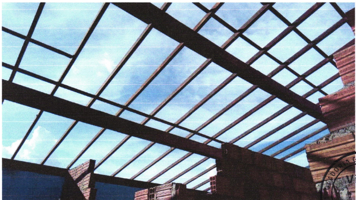
Foto 14 - Retelhamento em cobertura com telha ceramica tipo canal comum, Itabaiana ou similar.
