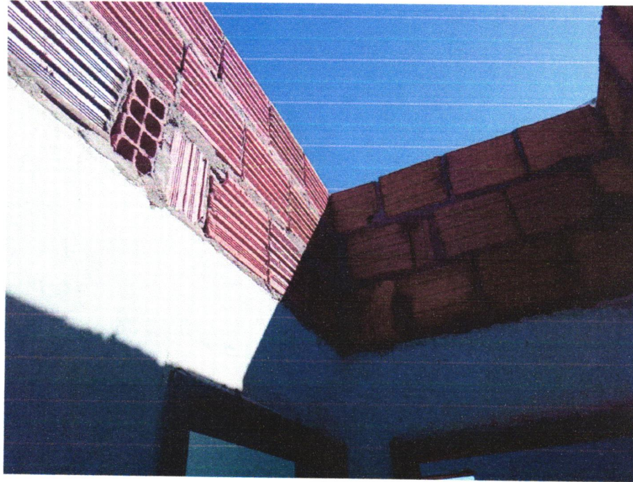
Foto 07 - ALVENARIA DE VEDAÇÃO DE BLOCOS CERÂMICOS FURADOS NA HORIZONTAL DE 9X19X29 CM (ESPESSURA 9 CM) E ARGAMASSA DE ASSENTAMENTO COM PREPARO EM BETONEIRA. AF_12/2021
